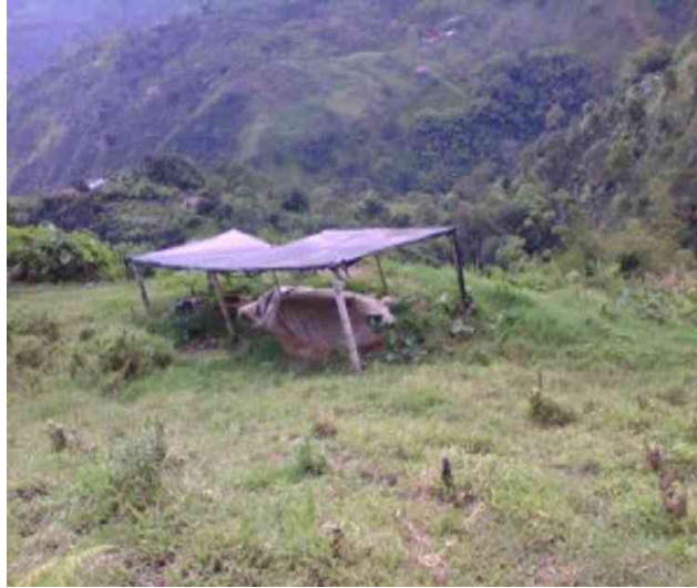
Biodigestor en la finca de don Elmer en Brisas del Guarinó. Utilizaba cachaza de molederos cercanos en el biodigestor.
